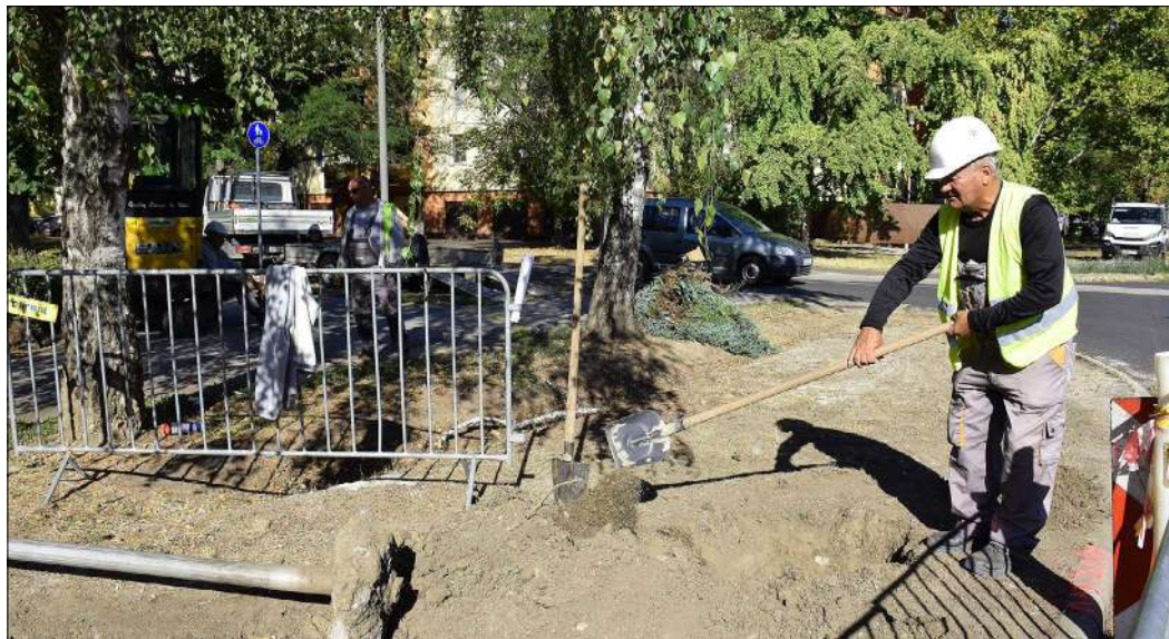
A Kazinczy utcai zebránál javában zajlanak az építés-előkészítési munkák
