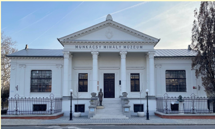
Múlt évben megújult a múzeum épületének homlokzata
