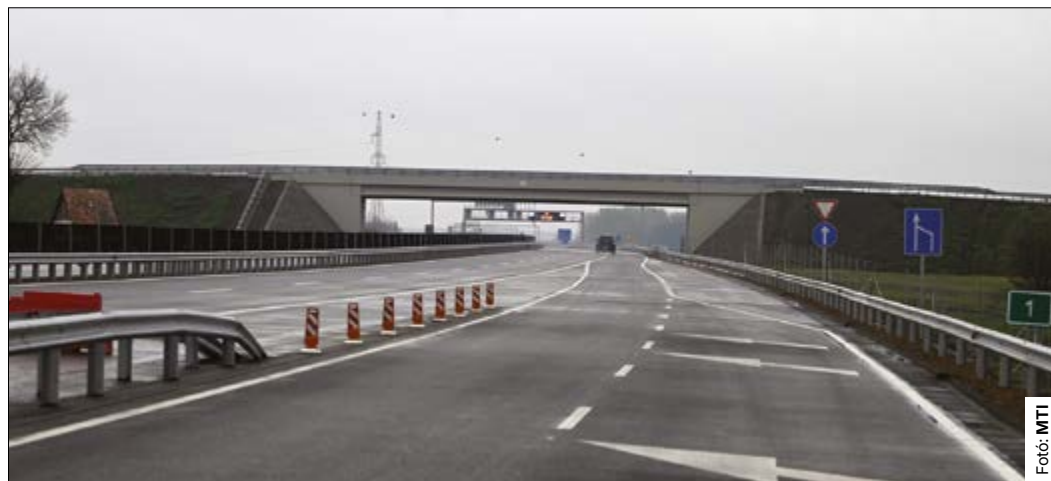
Az összesen 125 kilométer hosszú út 9 év alatt, 543 milliárd forint hazai forrásból épült
