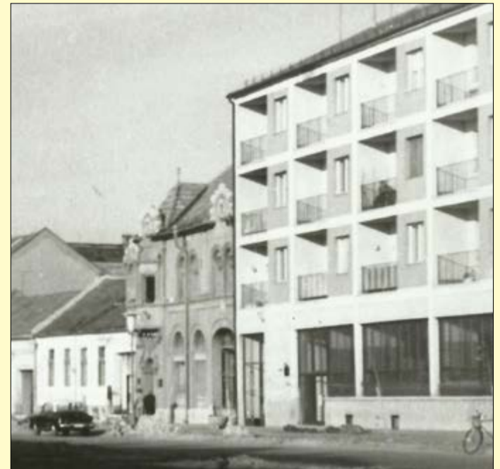
Az egykori Corvina könyvnyomda épülete a jobb oldali emeletes ház területére esett
