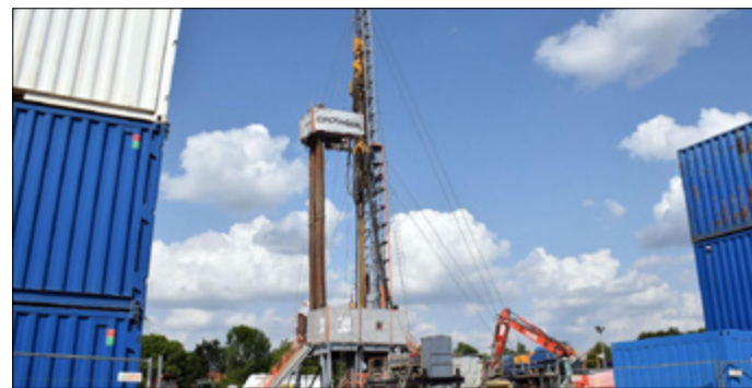
Geotermikus rendszer kiépítése a Gyulai úton
