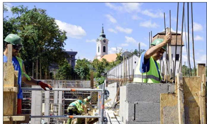
A bábszínháznál az új szárny építése is elkezdődött
