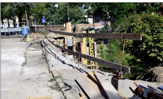
Épül a Kiss Ernő és a Kórház utcai híd
