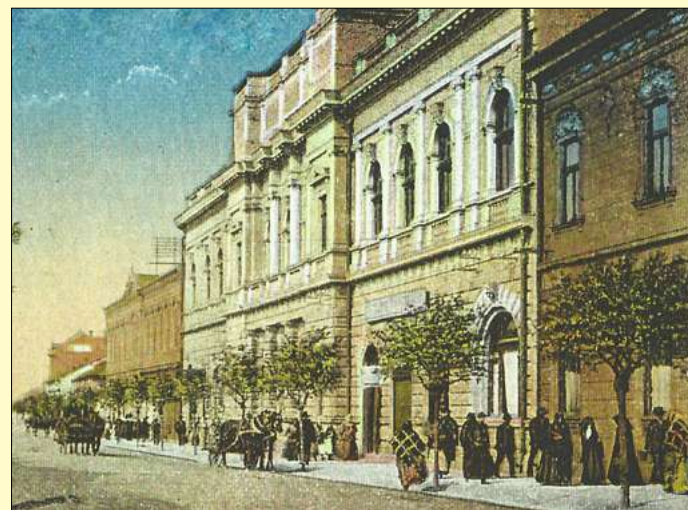
Életkép 1925-ből a színház előtti új betonjárda vázakkal
