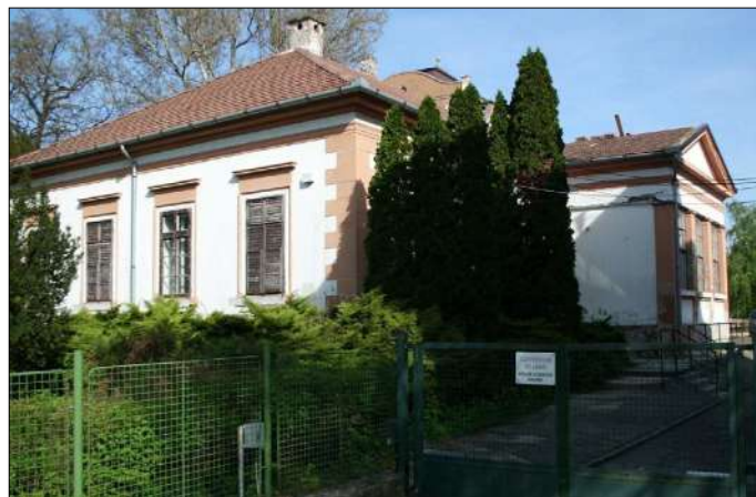
A kúria épülete jelenleg rossz állapotban van
