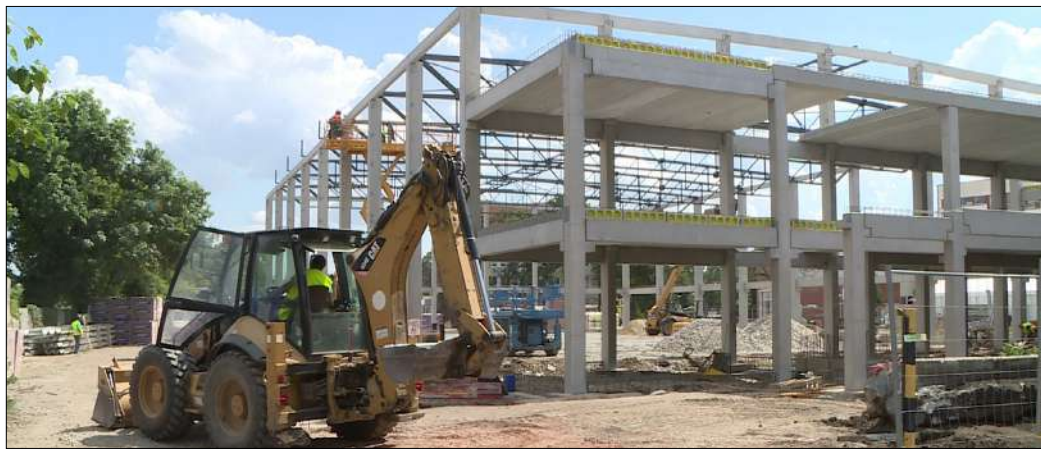
A szakemberek elkészítették az épület alapszerkezetét
