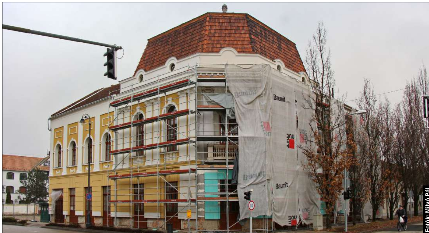
A Balassi Bálint Művészetek Háza energetikai korszerűsítése idén tavasszal fejeződik be
