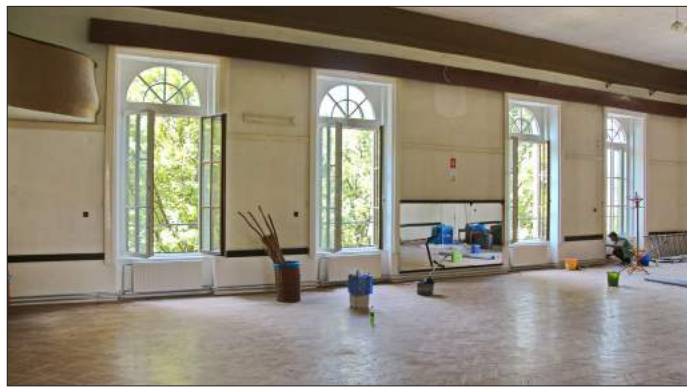
Energiatakarékosabb, korszerűbb lesz az épület
