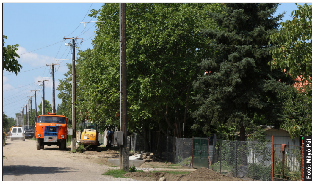
A terveknek megfelelően folynak a TOP-6.3.3-16-BC1-2017-00001 azonosítószámú, „Békéscsaba csapadék- és belvízhálózat-fejlesztése” tárgyú projekt megvalósításának építési munkái
