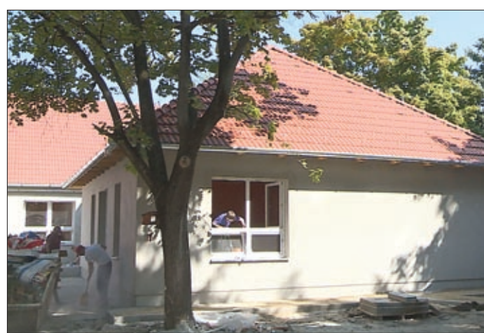
A Tábor utcai óvoda még a felújítás közben
