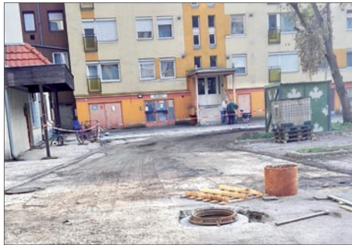
Az Andrássy út 16–18. belső udvarának felújítása
