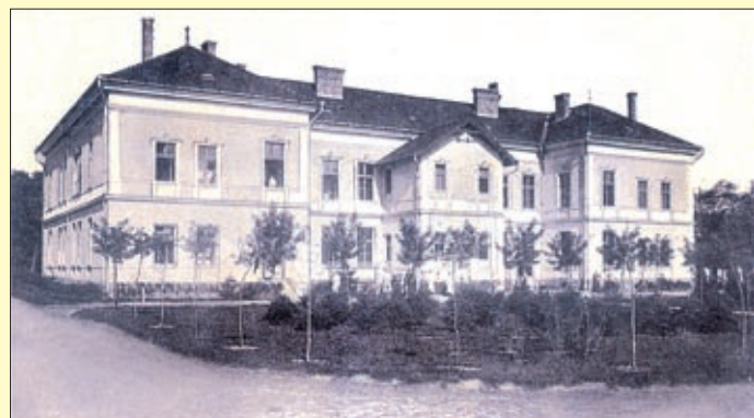
Az első kórházi pavilon épülete
