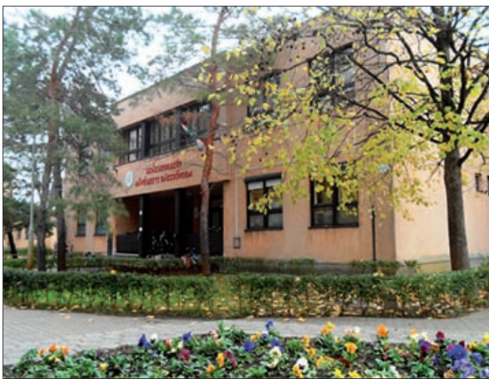
Három óvodát újítanak fel a közeljövőben
