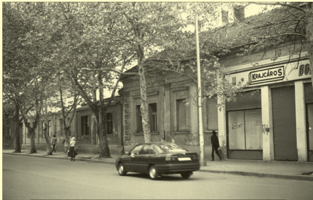
Az Andrássy úti volt polgárházak bontása 1993-ban. Furcsa volt a házak hült helye, de aztán itt épült meg a Csaba Center szórakoztató- és bevásárlóközpont
