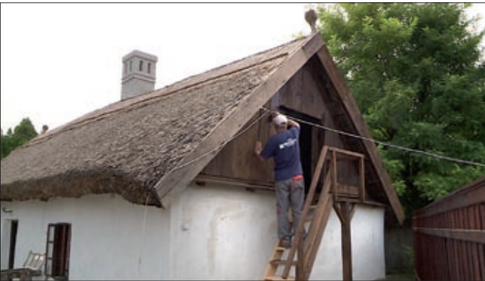
A ház felújítása rövidesen befejeződik
