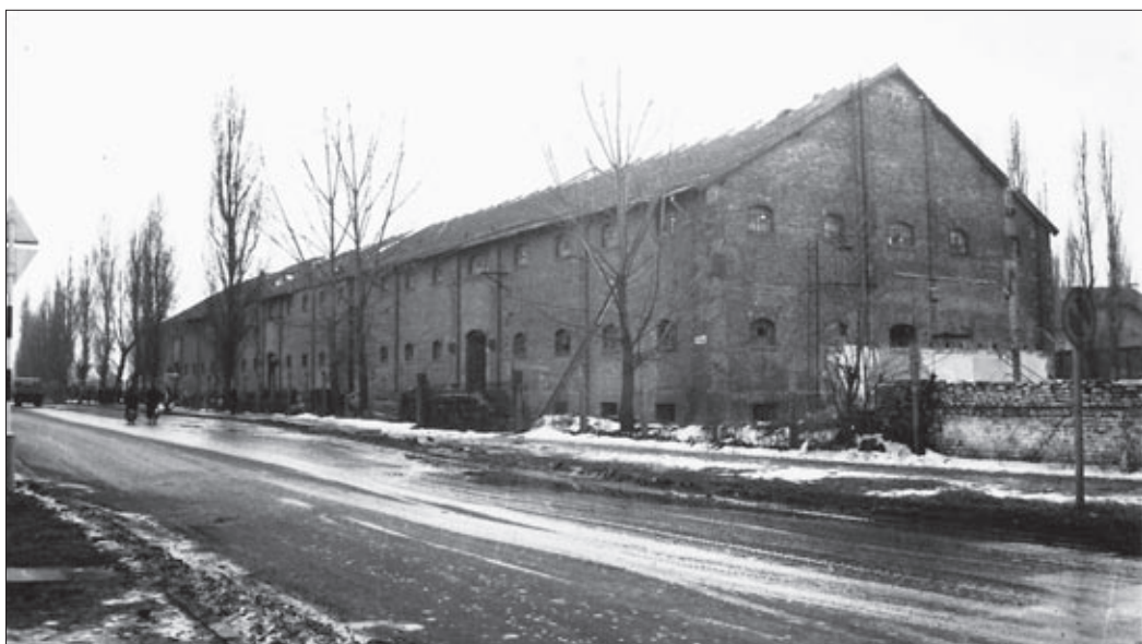
A vasútállomás melletti közraktár épülete évtizedekkel ezelőtt
