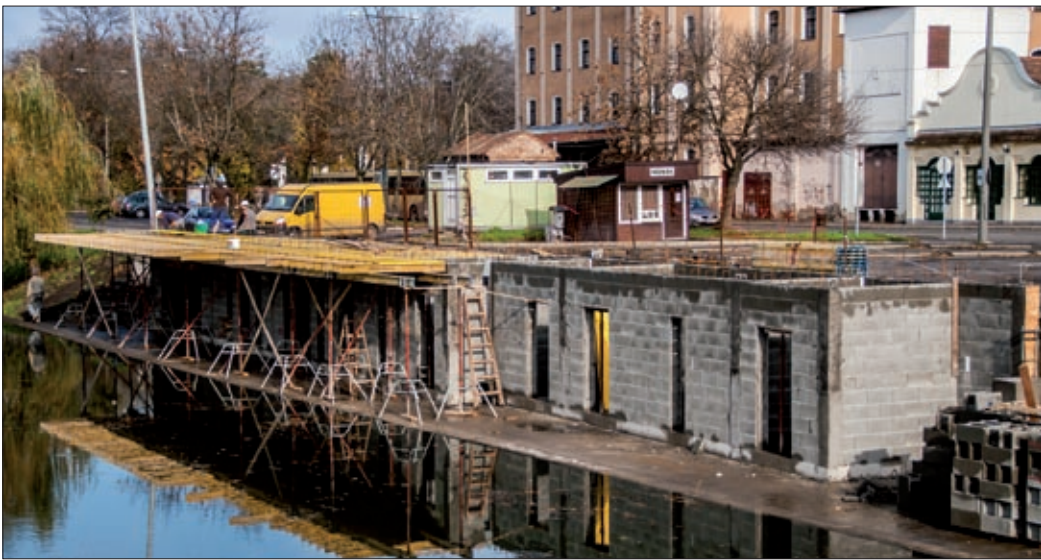
A partfalnál álló épület tetején lesznek majd a vasúti kocsik
