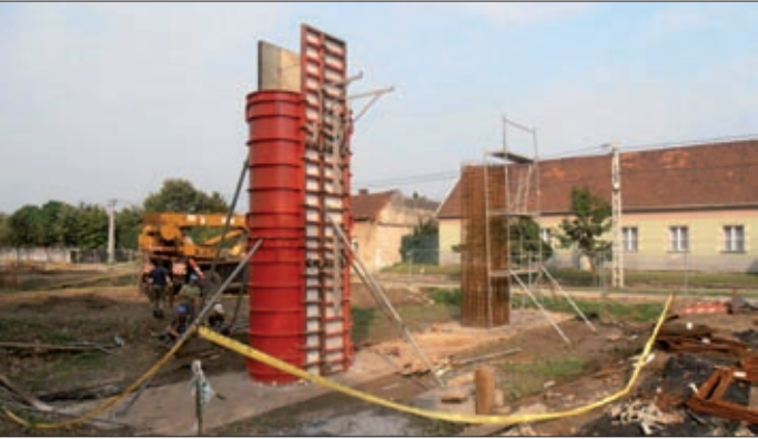
Az Orosházi úti felüljárónál a pillérek betonozása folyik
