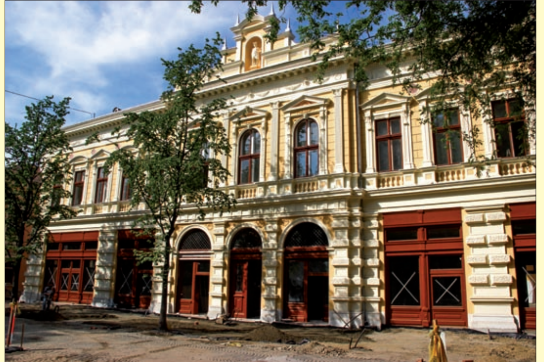
A Szent István tér 10. számú épület homlokzata a régi fényében pompázik
