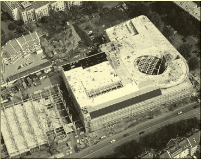
A Csaba Center építése madártávlatból
