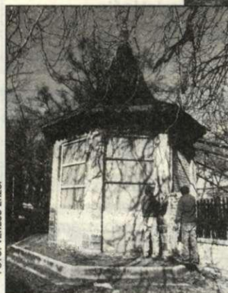
Az átalakított zenepavilon az 1950-es években sokáig büféként szolgált. Régóta üresen áll. A romló állagú épület falát vandálok bedöntötték, a napokban falazták vissza, és a leszakadt tetőt is helyreállították
