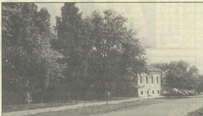
A hajdani első kád- és gőzfürdő épülete ma
