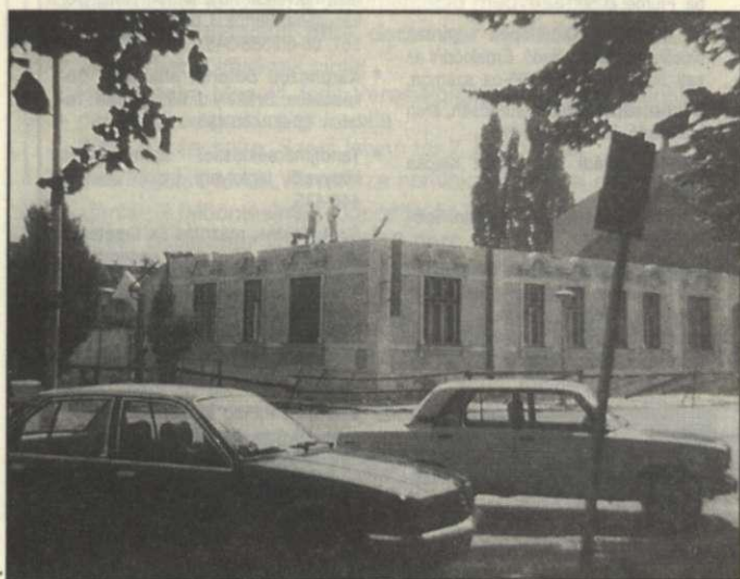
A régi ház tető nélkül, elkezdődött a szlovák kultúrközpont építése
