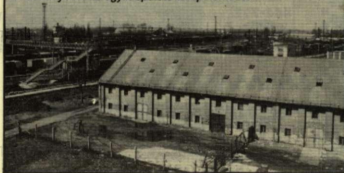
A dohánybeváltó egyik épülete a repülőhíddal
